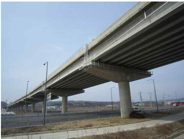
9공구 고현천교 (9공구)
