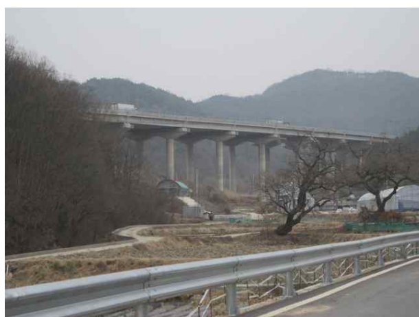
5공구 오로교 (5공구)
