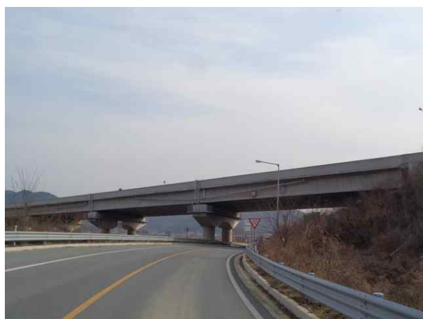
3공구 신계교 (3공구)
