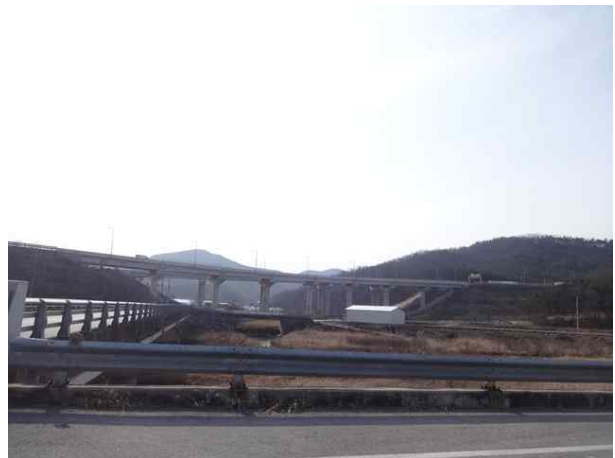
5공구 군위JCT R-C교 (5공구)
