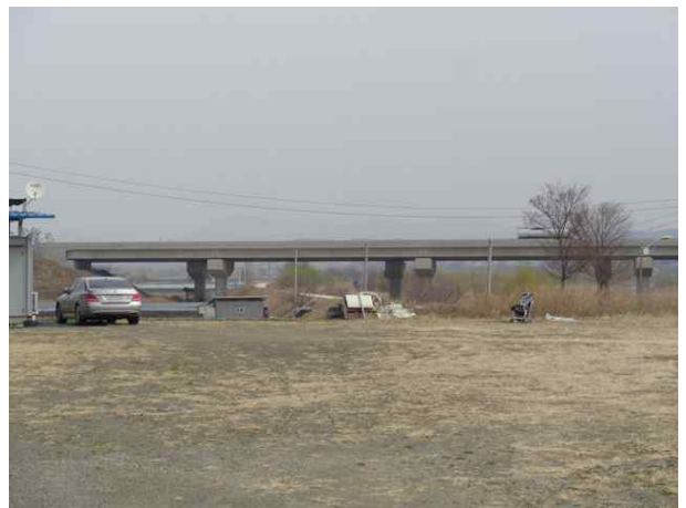
10공구 산하교 (10공구)
