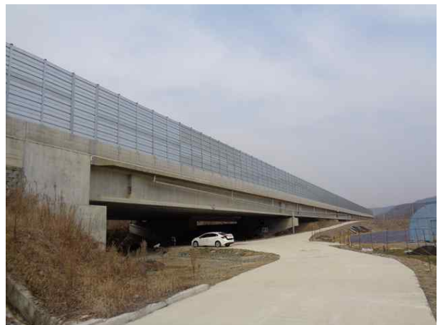
6공구 금매교 (6공구)
