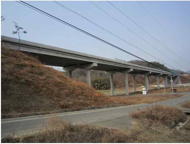
9공구 가래실교 (9공구)
