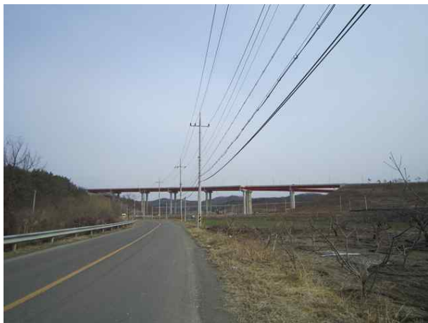
8공구 화산JCT RAMP-A1교(8공구)
