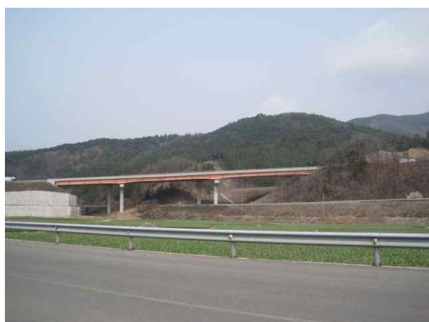
7공구 화남교 (7공구)
