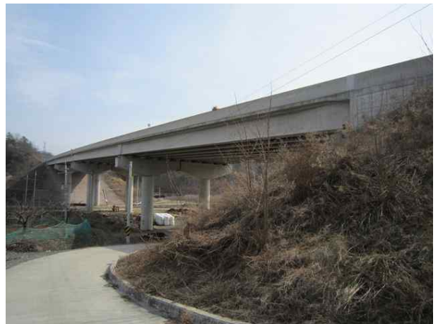
9공구 도림천교 (9공구)
