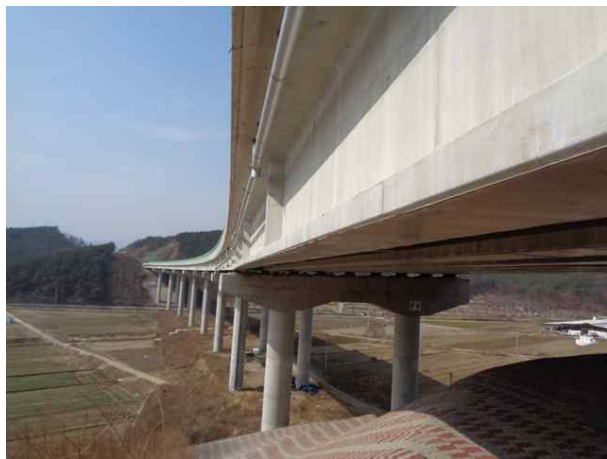
3공구 도개교 (3공구)
