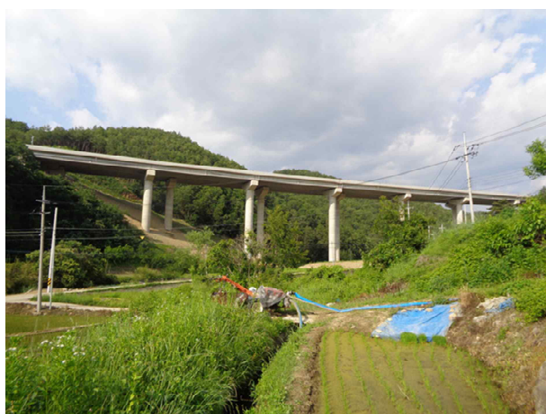
4공구 산호교 (4공구)
