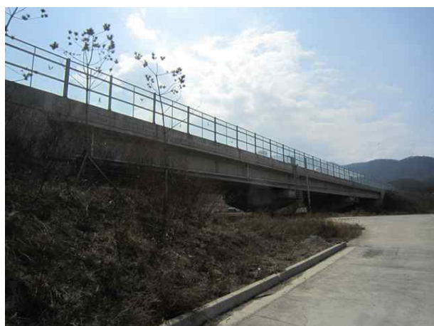
7공구 배골교 (7공구)
