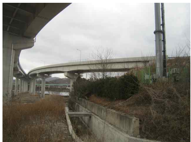
10공구 영천JCT Ramp-B교(10공구)
