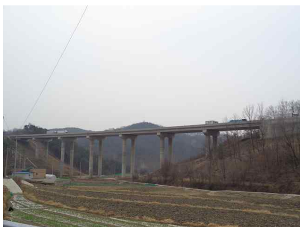
5공구 오실교 (5공구)
