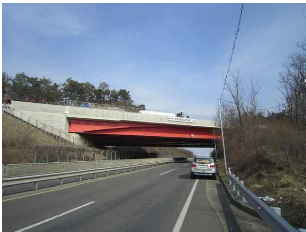
9공구 오미교 (9공구)
