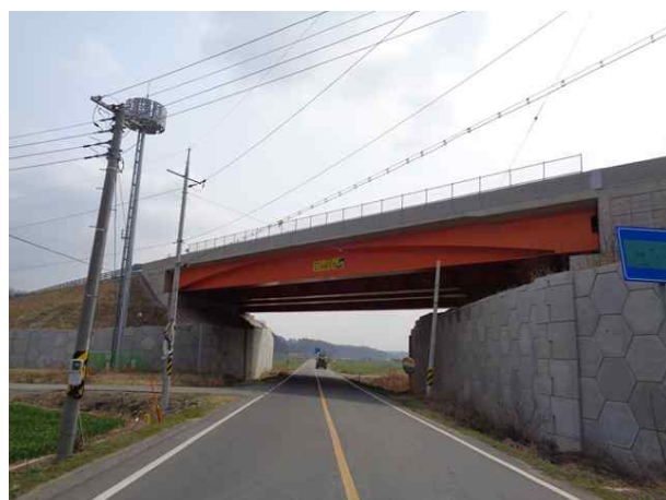
7공구 화남1교 (7공구)
