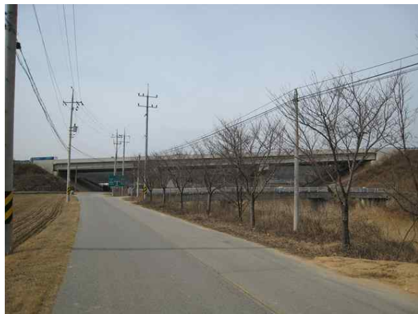
2공구 월가교 (2공구)
