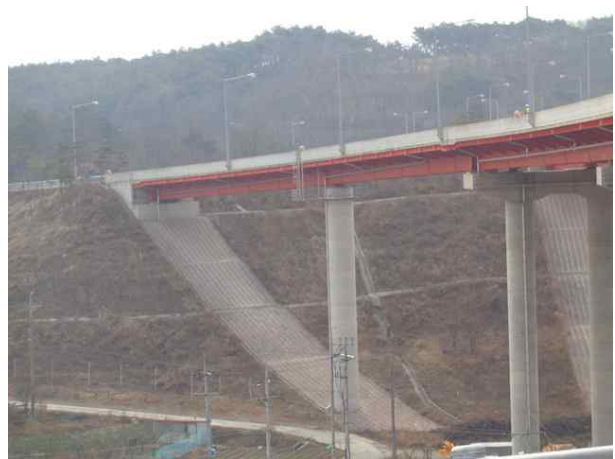
8공구 화산JCT RAMP-H교(8공구)
