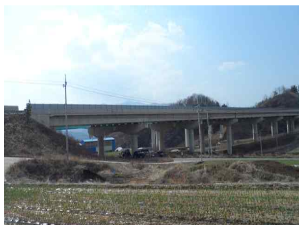
8공구 가천교 (8공구)
