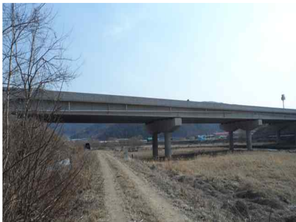
6공구 창기교 (6공구)
