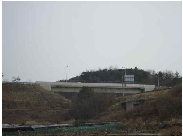
8공구 화산JCT RAMP-A교(8공구)
