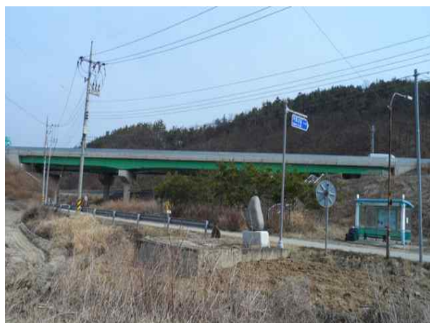
6공구 가호교 (6공구)
