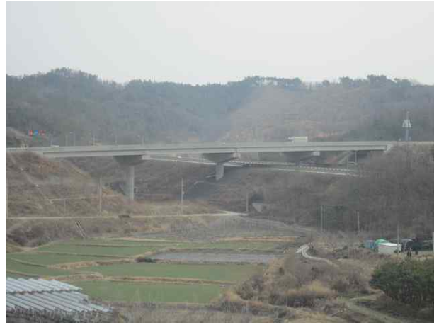
9공구 암기교 (9공구)
