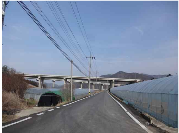
5공구 내리교 (5공구)
